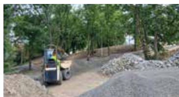
Stavební práce nad historickými pivovarskými sklepy postupují. V místě mezi Tescem a infocentrem vzniká nový městský park, který se už rýsuje v terénu. Foto: Město Jirkov
