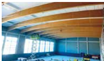
Interiér nové sportovní haly v Jirkově, kde finišují práce na instalacích a konstrukcích. Foto: město Jirkov
